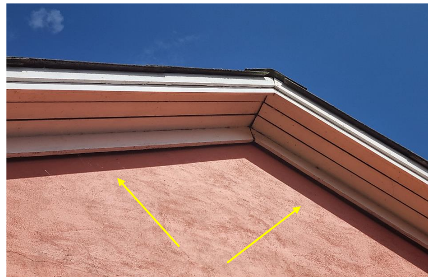
Spalter mellem mur og udhængsafdækning
