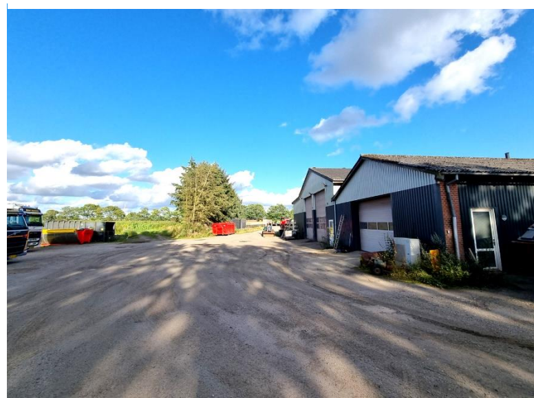
Foto 4. Den nordlige afgrænsning af bygningerne Vejle Landvej nr. 33
